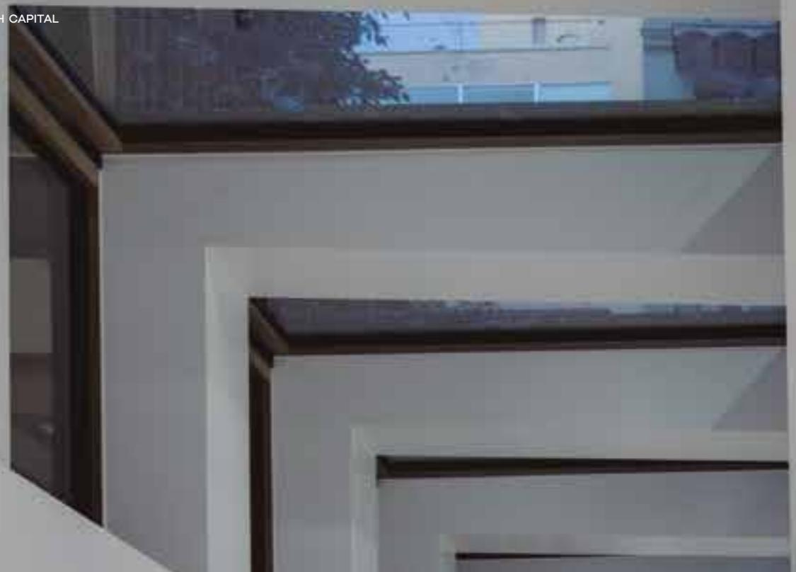
Se ha creado una estructura de columnas dispuestas en ángulo recto que sostienen una gran cristalera y crean un conjunto geométrico que, para no perder la luz natural, convive en perfecta armonía con las escaleras mecánicas y el resto de la planta.
